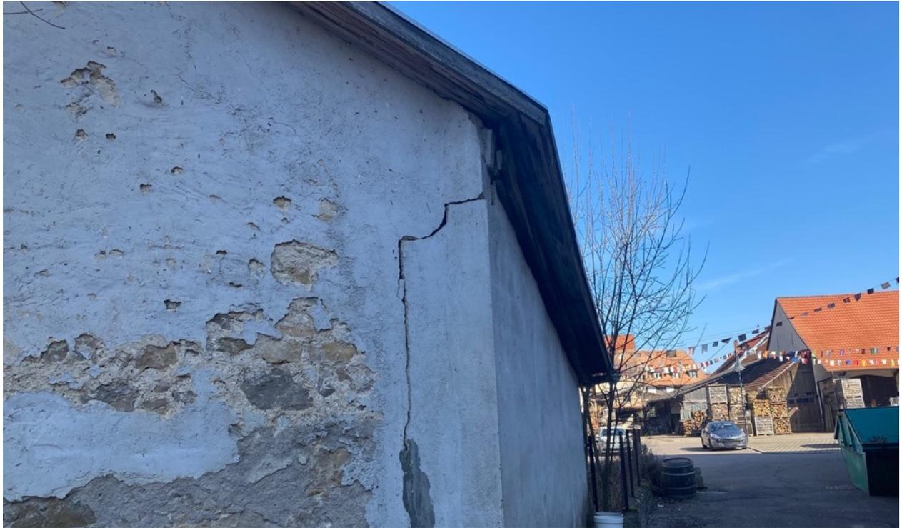
Abb. 25: Fassadenriss südlicher Schuppenkomplex
