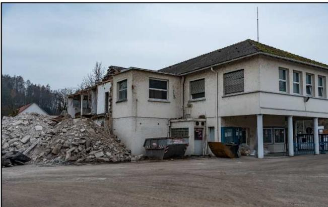
Beim Abbruch des Verwaltungsgebäudes fallen ca. 4500 Tonnen mineralischer Bauschutt an. Ziel ist es so viel als möglich vor Ort für die weitere Verwendung aufzubereiten. 4500 Tonnen Bauschutt, das entspricht ca. 188 LKW-Ladungen.
